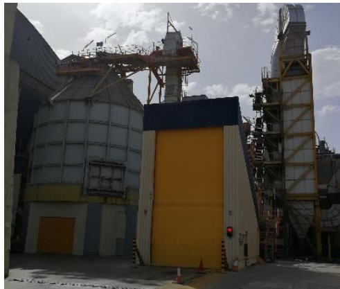
Figura 14. Instalação de CDR's do Centro de Produção de Alhandra, Cimpor
